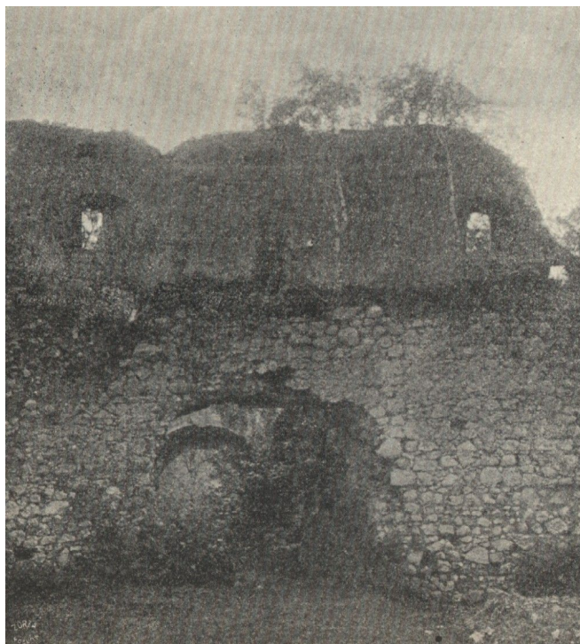
Fig. 5. Korzkiew, zameczek, widok muru obwodowego od strony dziedzińca. Fot. autora.
