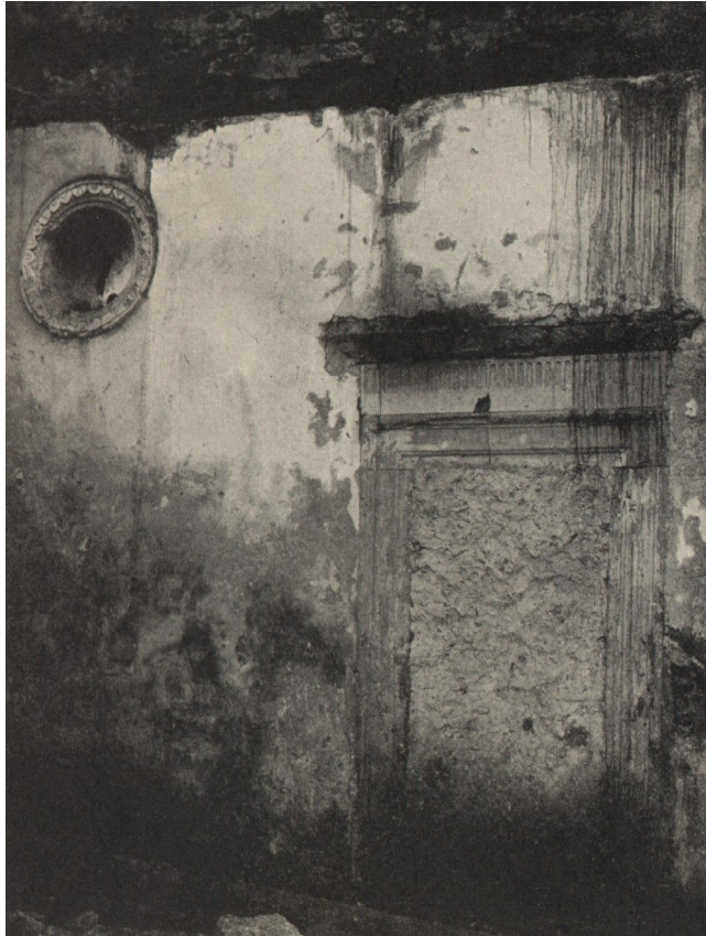
Fig. 8. Korzkiew, ściana z oknem i drzwiami. Fot. autora.
